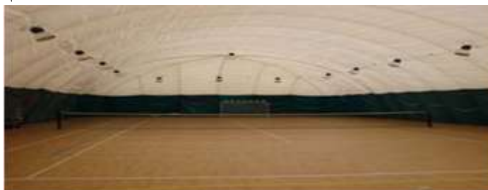
Рисунок 1. Внутренний интерьер торообразного сооружения.
