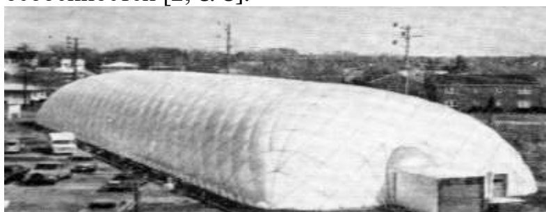
Рисунок 1. Воздухоопорное сооружение, усиленное канатами со средней ячейкой.
